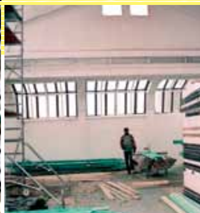
• Východiskový stav a priebeh rekonštrukcie – Veľká výstavná sála
