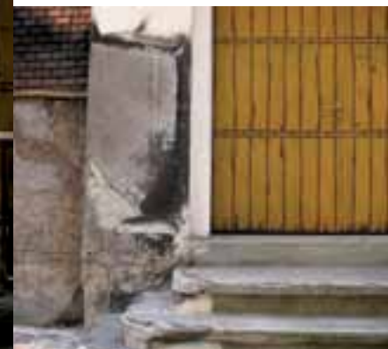
• Detail nevhodnej plechovej brány do menšej výstavnej sály, tzv. Kameňáku, a celkového poškodenia prvkov budovy
