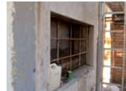
• Detaily dokumentujúce stav budovy pred rekonštrukciou (zo strany od Euroveji)
