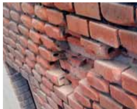
• Detaily fasády v priebehu rekonštrukcie, ukážka deštruovaných múrov stavby
