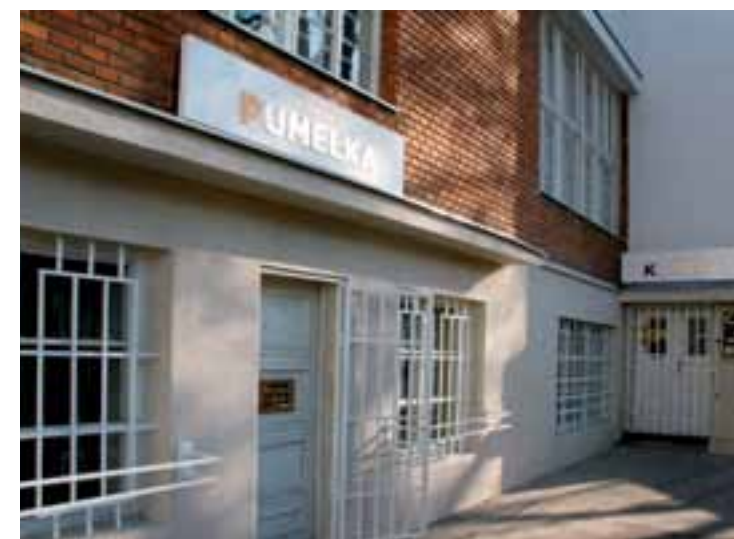
• Stav budovy po ukončení súčasnej etapy rekonštrukcie (zo strany od UK)
