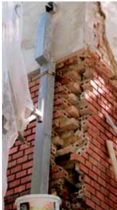
• Detail vážne poškodeného obvodového múru: roh budovy pred a po rekonštrukcii
